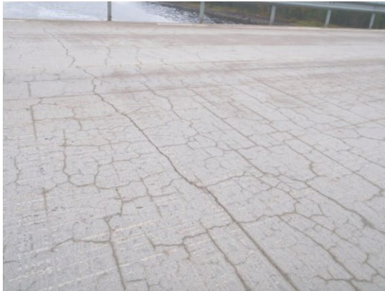
Vindelälven, N Åmsele, bro 24-673-1
