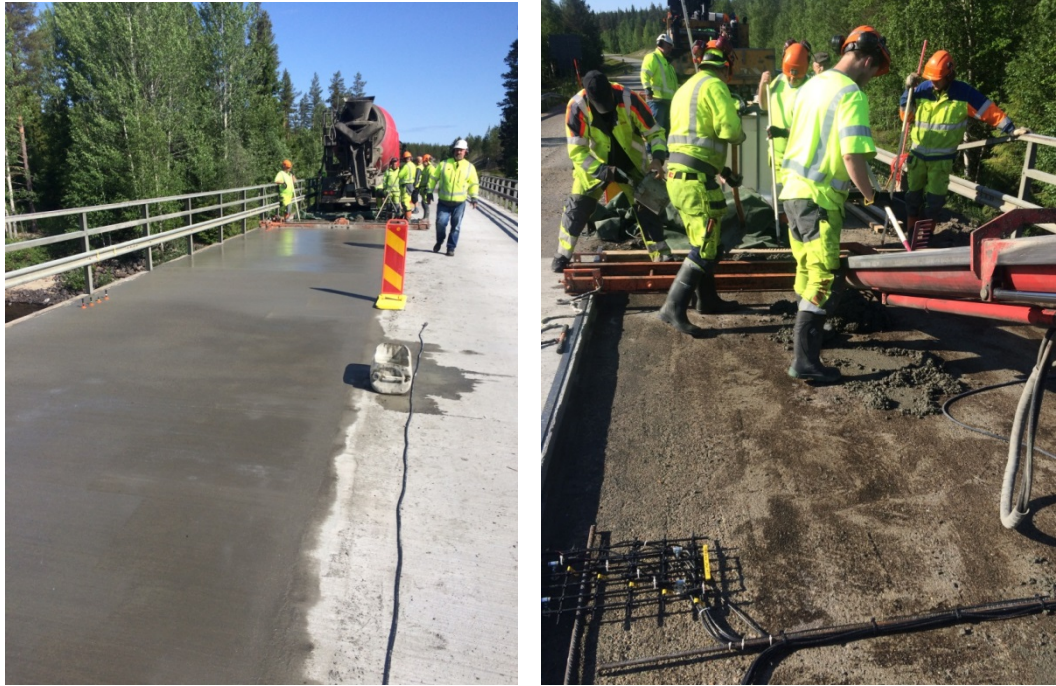
Figur 4.9 Bro över Öre älv byggd 1965, gjutning av slitbetongskikt, juli 2015.
