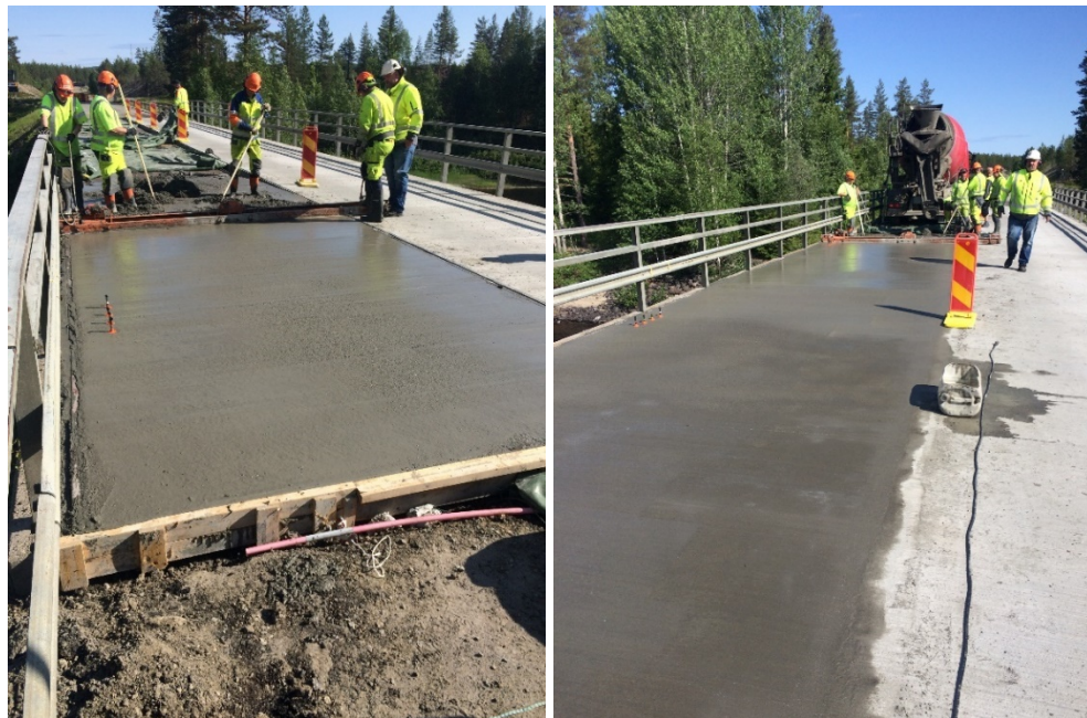
Figur 1.3 Typiska lösningar för brobanepaltor och exempel på brobanereparation med direktgjuten slitbetong på en bro i närheten av Lycksele, 2015.
