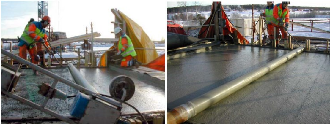
Figur 2.3 Gjutning av självkompakterande slitbetong med en försiktig ytvibrering i två omgångar, Jannok (2004).
