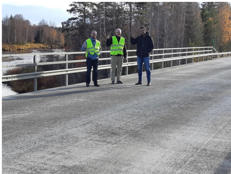
Figur 4.5 Bro över Öre älv, Västerbotten, inspektion av projektgrupp från LTU oktober 2018 på bro som studerats i fullskaleförsök tre år tidigare. (foto Mats Emborg).
