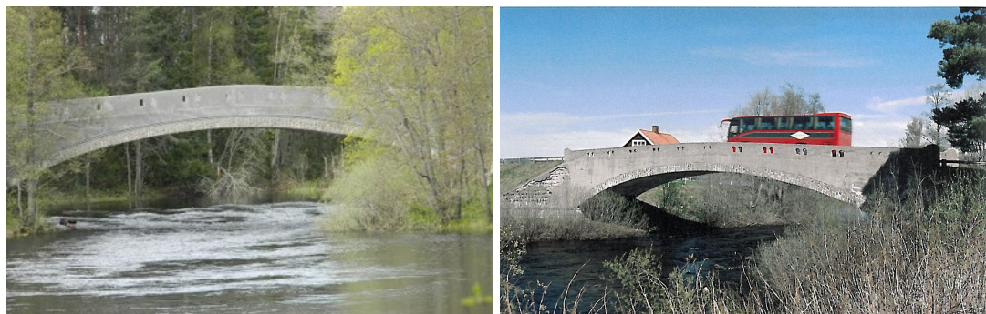
Figur 1.1 Bro över Testeboån, NV Ockelbo. Oarmerad betong, byggd 1916
